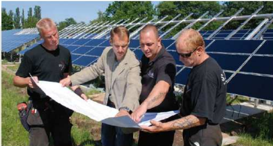
Realität und Plan stimmen überein. Der Projektleiter der Berliner Wasserbetriebe, Harry Rauch (2.v.l.), und der Projektleiter der Solar Gruppe Nord, Dirk Gnausch (2.v.r.), die die Anlage nach den Plänen der Wasserbetriebe montieren, bei einer Beratung vor Ort. Im Hintergrund die neue, zum Teil fertiggestellte Photovoltaikanlage am Tag der Aufnahme Anfang Juni.
